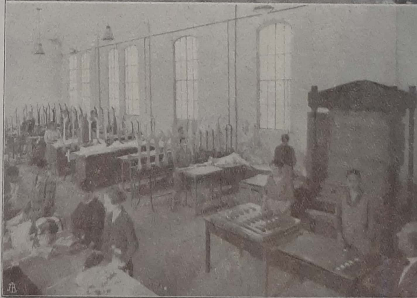
Le maggiori industrie lancianesi: Il Calzificio Umberto, Gaspare e Alfredo fratelli Torrieri. — Dall'alto: Il prospetto principale dello stabilimento. — Una delle sale delle macchine. — La sala della stiratoria.
